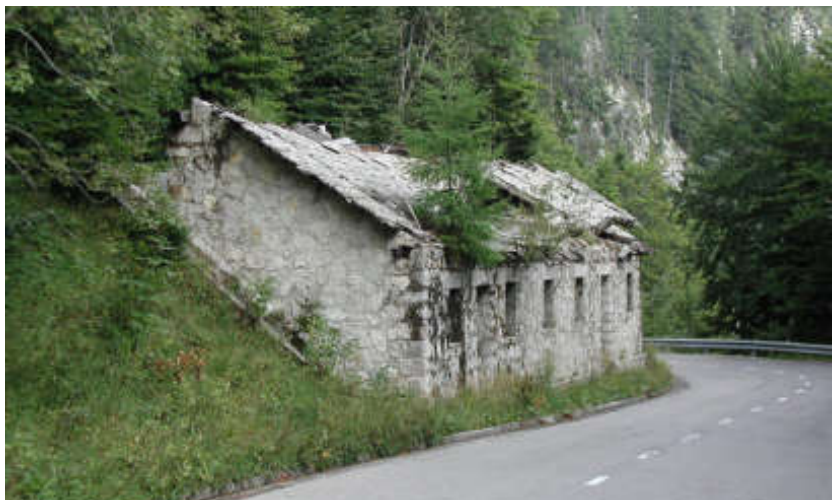
ehemaliger Posten an der Aufmarschstraße Predil Pass (Foto Thomas Heintz)
