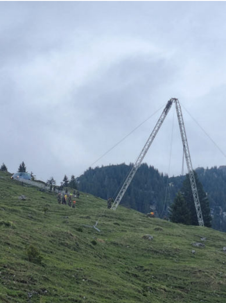
Der A Stützmast steht nach harter Arbeit
